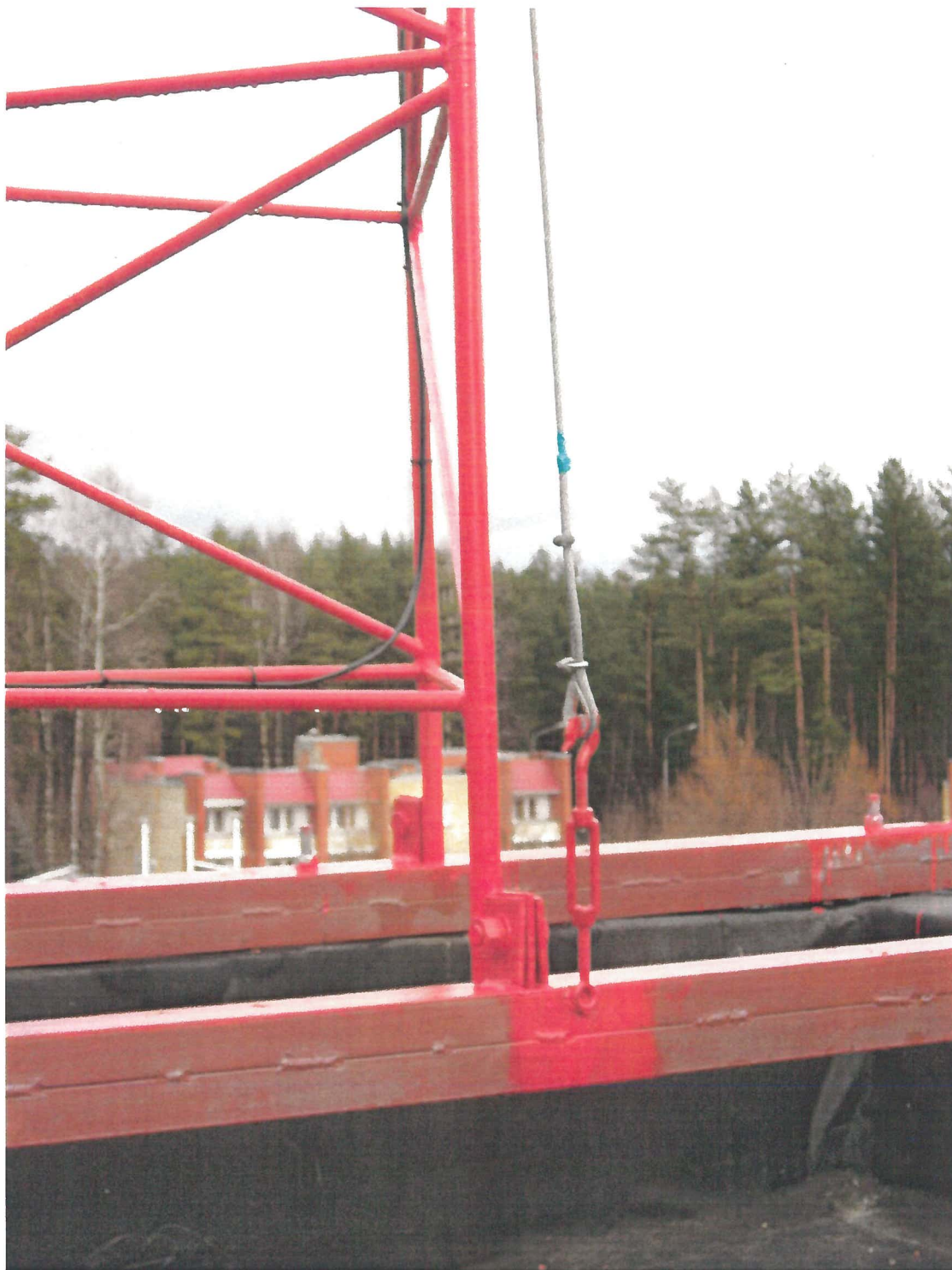
13 pav. Apsauginio lino tvirtinimas bokšto apačioje
