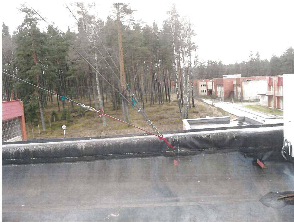
10 pav. Trečios atatampos tvirtinimas
